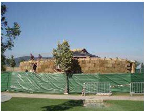
La carpintería tanto exterior como interior es de madera y los suelos del edificio están hechos con la tierra extraída en la excavación del terreno, compactada con un poco de cal y de arena y posteriormente impermeabilizada con aceite de linaza.
