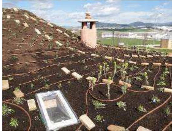
La cubierta del edificio lleva una capa inferior de paja y sobre ésta una cubierta verde. Una cubierta plantada con diferentes especies vegetales que a la vez que supone un importante aislamiento por la capa de tierra que lleva, mejora el comportamiento térmico del edificio y crea una ornamentación que va a integrar más si cabe el edificio en el Parque de los Sentidos. Lugar donde se ubica el edificio y zona verde emblemática en Noáin.
