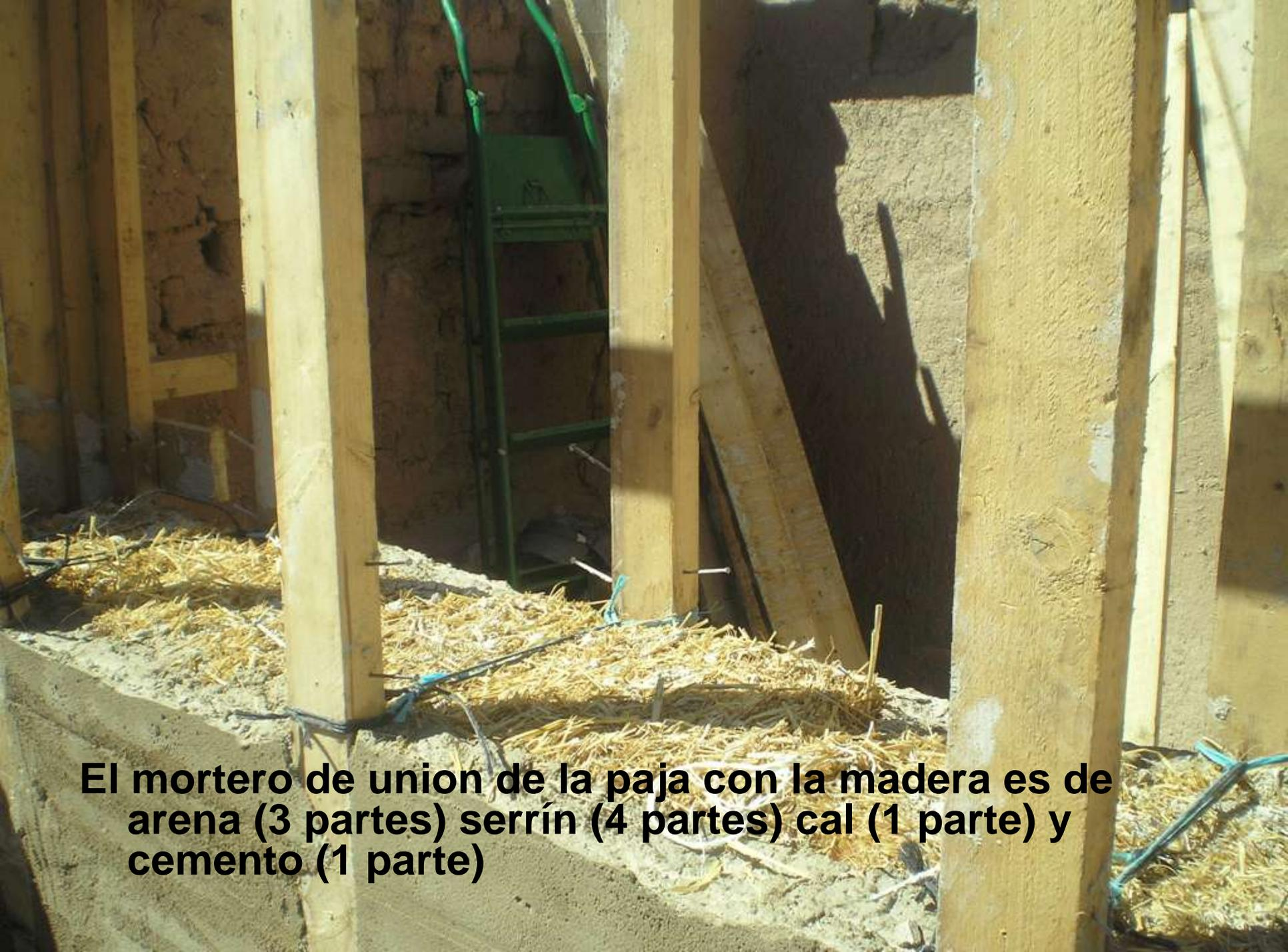
**El mortero de union de la paja con la madera es de arena (3 partes) serrín (4 partes) cal (1 parte) y cemento (1 parte)**
