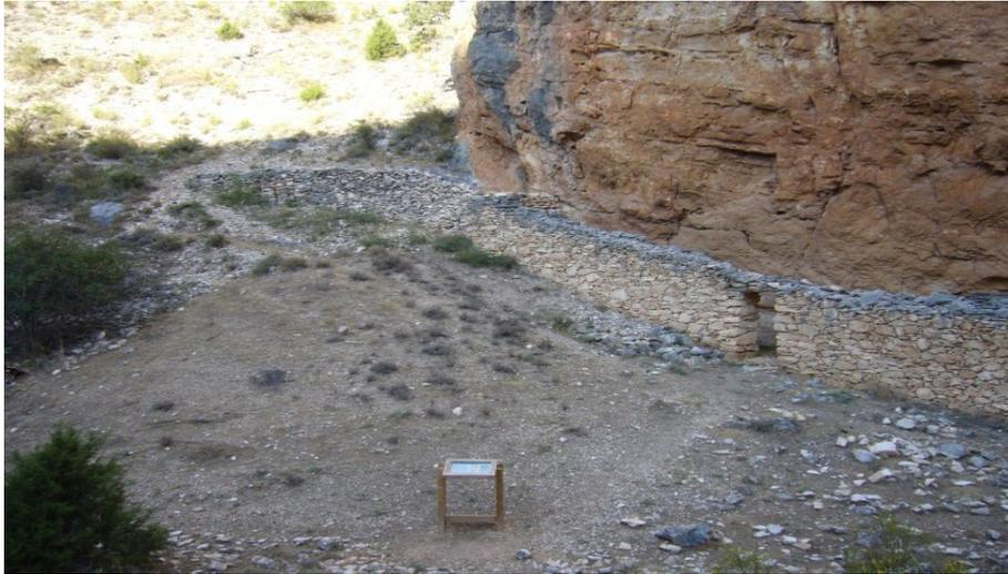
2. Restauración de las caleras u hornos de cal, mediante limpieza y desbroce del entorno, vaciado y extracción de tierras de su interior, reconstrucción hipotética de su planta y estructura mediante unas cuantas hiladas de mampuesto del lugar.
