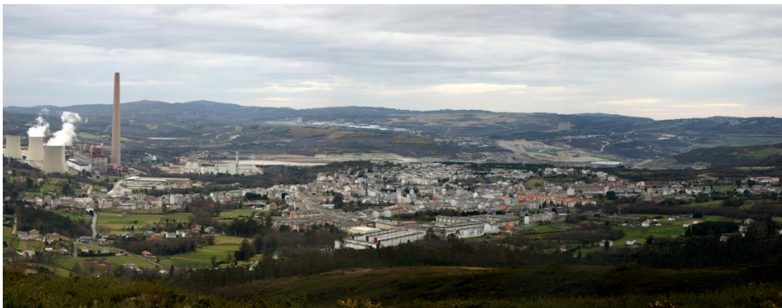
Vista panorámica del municipio de As Pontes, con la Central Térmica y con el inmenso hueco de la mina de lignito pardo al fondo.
