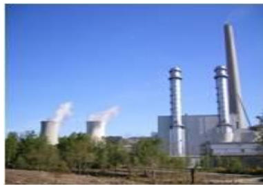
Vista de las instalaciones de Ciclos Combinados
