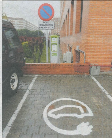
Punto de recarga de vehículos eléctricos. CCS
