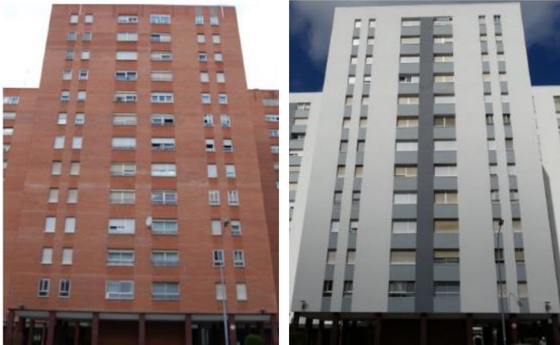
Figura 1. Rehabilitación de los edificios
