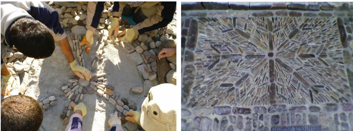
Ejemplo de práctica conjunta de diseño de empedrado con canto rodado seleccionado y resultado posterior, tras relleno de las juntas con mortero.
