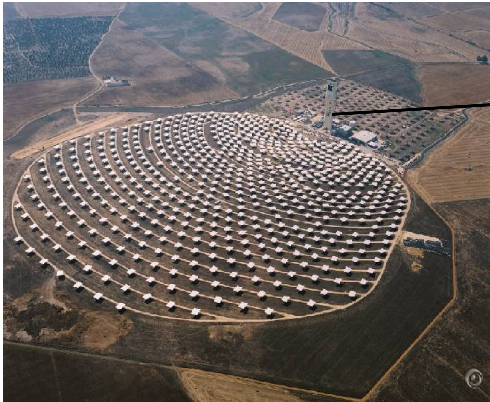
Vista aérea de la Planta PS-10 de Abengoa (Sevilla)
