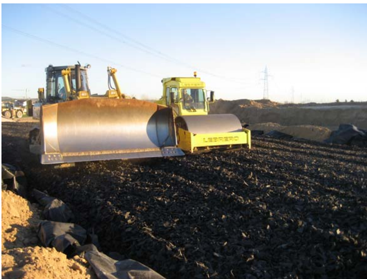
Figura 4. Extendido y compactación de NFU triturados
