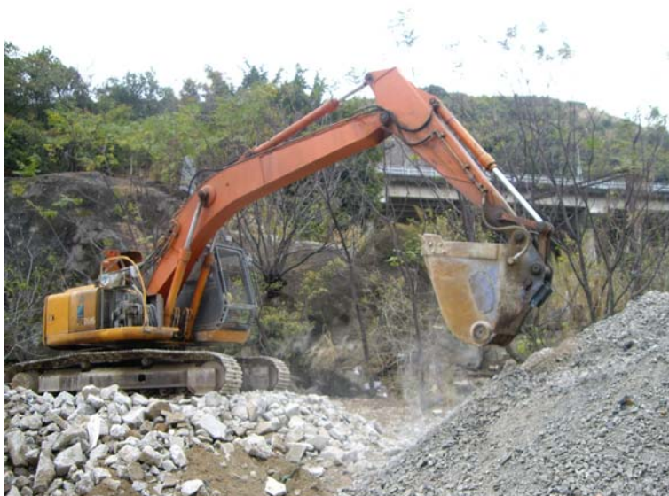
Figura 3. Reciclaje de áridos en obra
