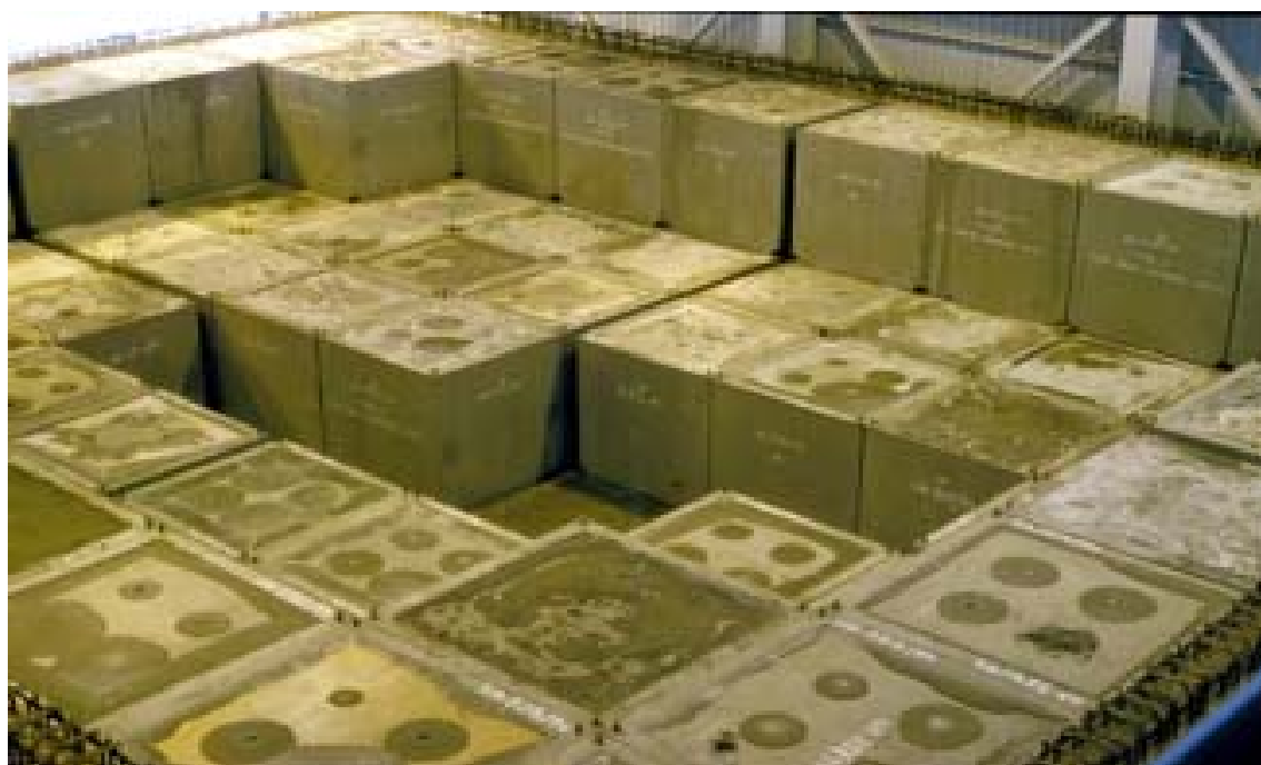
Interior de una celda para el almacenamiento de contenedores de residuos de baja y media actividad. Centro de Almacenamiento de El Cabril.
