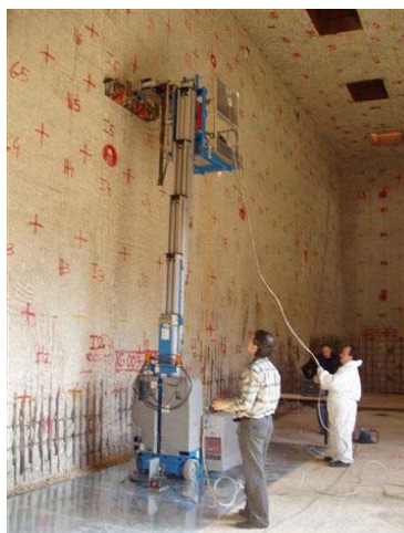
Trabajos de desclasificación de superficies
