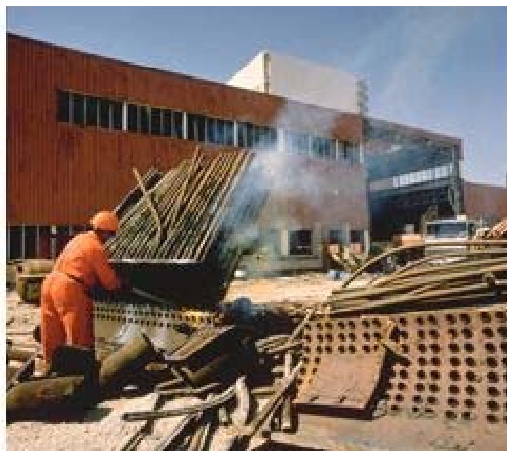
Trabajos de desmantelamiento de equipamientos
