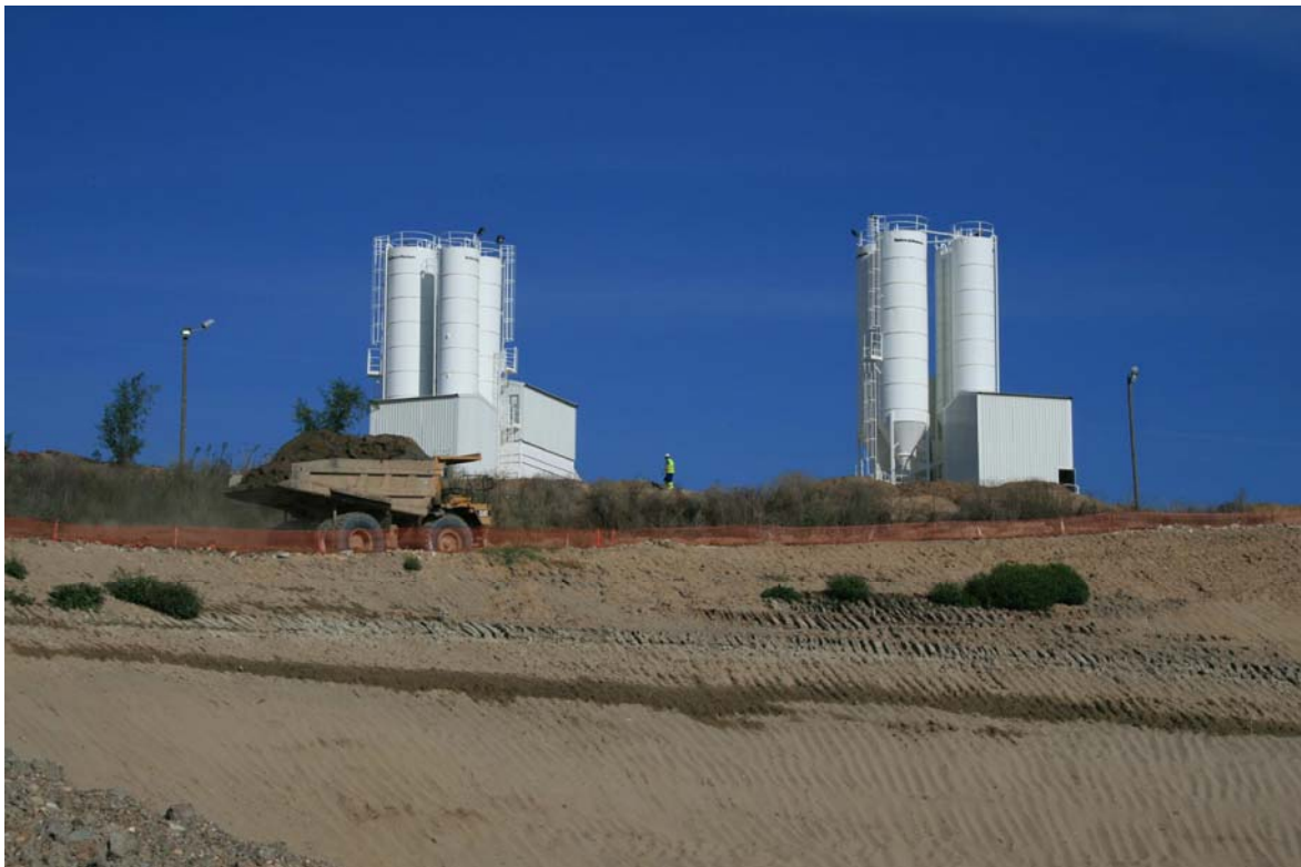
Figura 15. Plantas de hormigón
