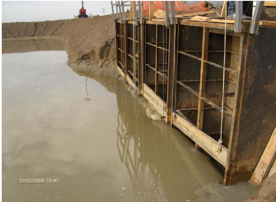
Figura 8. Detalles de los cajones de control del vertido. La disposición de las tablas, disminuye el caudal de salida aumentado su tiempo de residencia, facilitándose la decantación de los sólidos en suspensión
