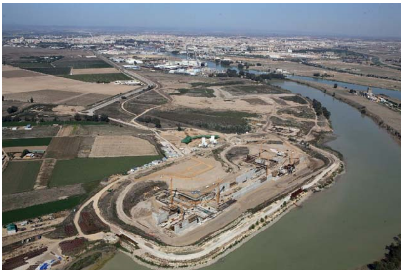
Figura 2. Estado actual de las obras de construcción de la nueva esclusa
