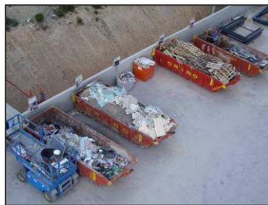
Imagen 4: Punto Limpio para almacenamiento de residuos: RCD's (izqda.) y RPs (dcha.)
