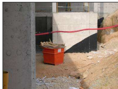
Imagen 6: Separación de residuos segregados en el tajo
