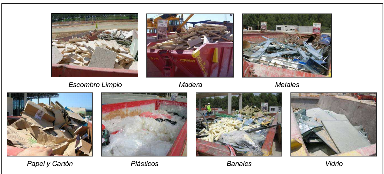
Imagen 1: Fracciones de RCD's separadas en obra
