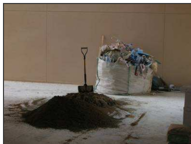
Imagen 6: Separación de residuos segregados en el tajo
