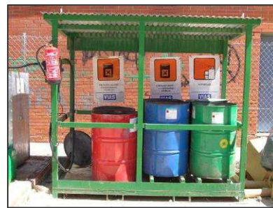
Imagen 4: Punto Limpio para almacenamiento de residuos: RCD's (izqda.) y RPs (dcha.)
