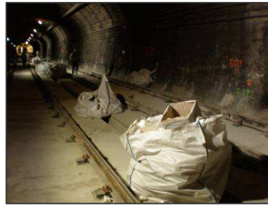
Imagen 3 bis: Contenedores tipo y sistemas de transporte distribuidos en obra
