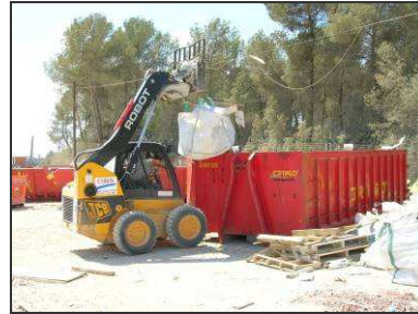
Imagen 7: Recogida de residuos segregados y transporte a Punto Limpio
