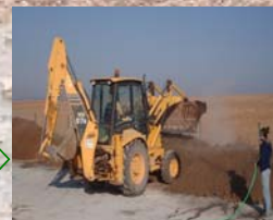
Figura 5. Volteo y riego de las pilas.
