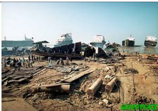
Buques en varias etapas de desguace en Alang
