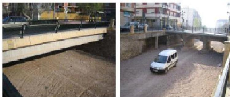
**Fig. 3.** Puentes encadenados en la rambla de la Santa (Sotana, Murcia). Las secciones son diferentes para el mismo caudal circulante y provocarán problemas de taponamiento en una avenida. En la fotografía de la derecha se observa la utilización habitual de la rambla como vía de circulación de vehículos (Fotografía: Jose A. Ortega).
