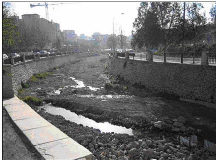
**Fig. 2.** Curvatura en la canalización de la rambla de la Santa (Sotana, Murcia). La velocidad de la corriente causada por la canalización hace de este punto un lugar de especial riesgo (Fotografía: José A. Ortega)
